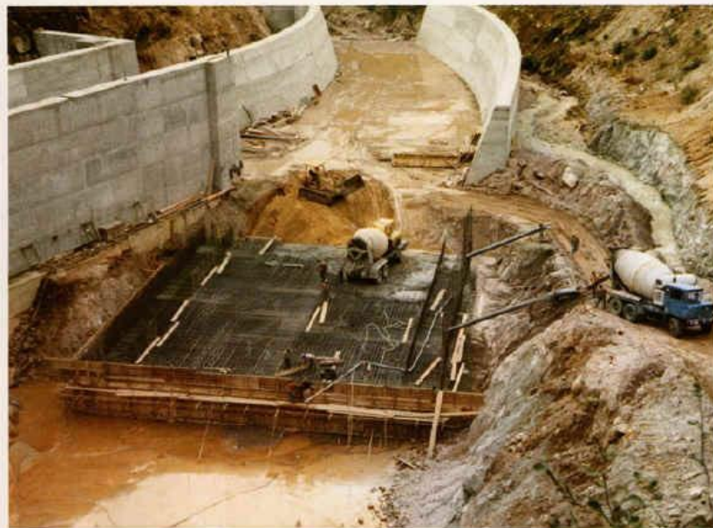
Vasca di smorzamento ▲
