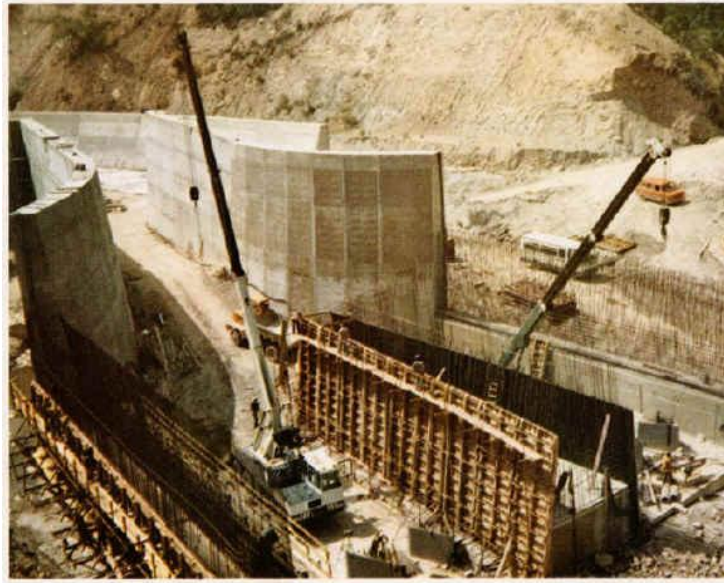
Vasca di smorzamento
